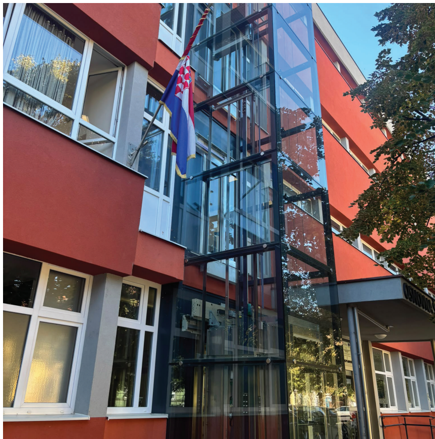
Novo dizalo s vanjske strane zgrade
