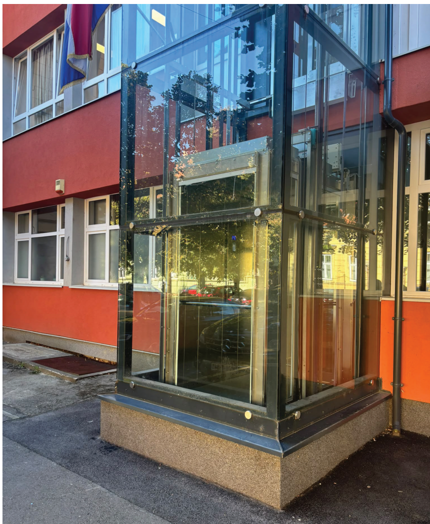
Novo dizalo ugrađeno na pročelje zgrade
