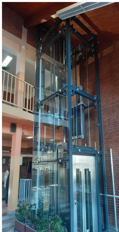
Novo dizalo ugrađeno u unutrašnjem prostoru
